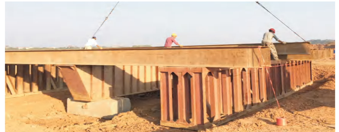
主梁、次梁的吊装
