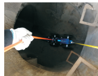
以中间挂钩为主要承力绳，尾部电缆调整方向，防止磕碰，到达底部前调平车身
