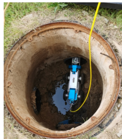
到达底部，确认进洞后，晃动线缆脱钩
