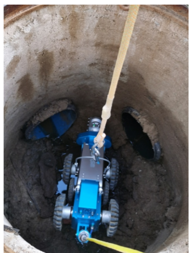
以中间挂钩为主要承力绳，尾部电缆调整方向，防止磕碰，到达底部前调平车身
