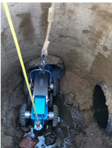
以中间挂钩为主要承力绳，尾部电缆调整方向，防止磕碰，到达底部前调平车身
