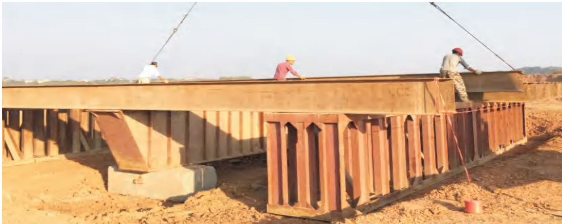
主梁、次梁的吊装
