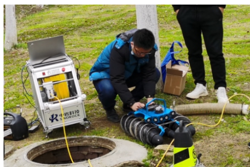
连接完成后，整体检查
