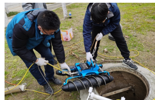
检查没问题，挂钩下吊
