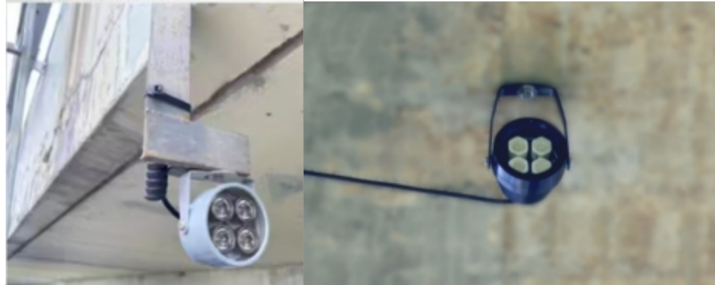
靶标灯现场安装示意图
